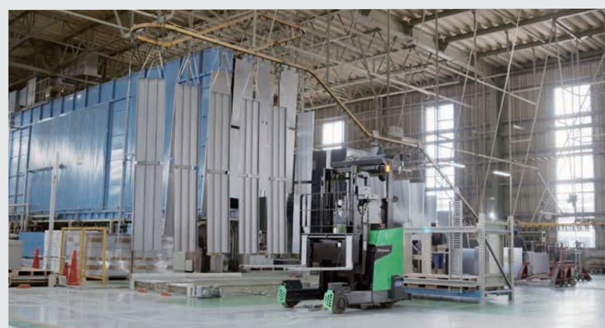
⑤塗装ラインに搬送 自動倉庫から荷取りした棚板を次工程の塗装ラインへ自動搬送。
