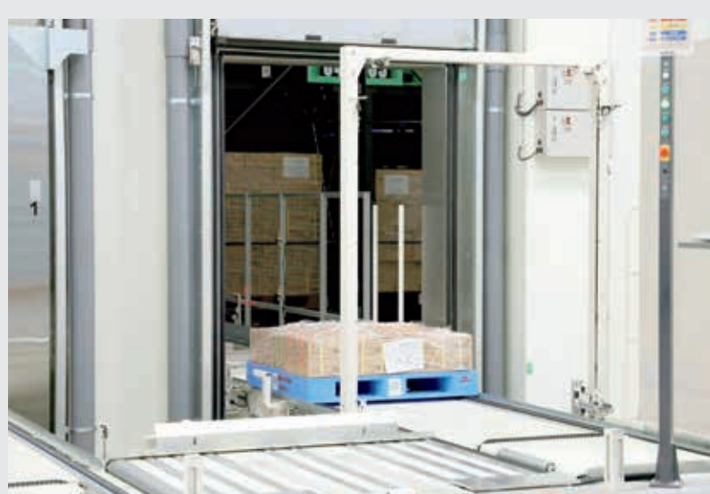
②入庫 ハンドパレットでコンベヤステーションにパレットを投入。倉庫制御システムIS-200に商品情報を登録すると、自動で入庫され、その後既存の上位WMSへ実績報告。
