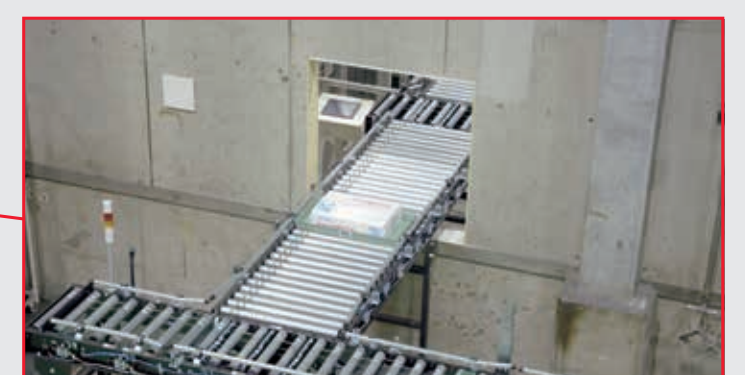
自動倉庫の背面からコンベヤで梱包工程と繋ぎ、入庫作業を効率化
