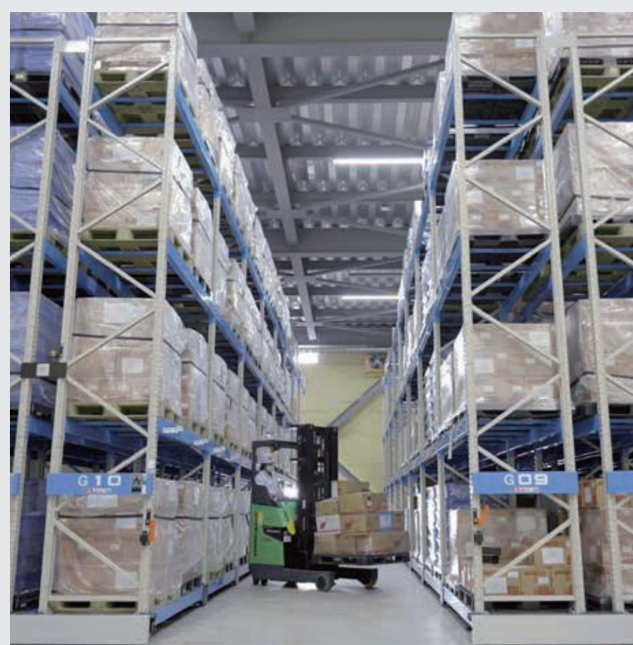
リーチフォークリフトが旋回できる通路スペースを確保。また、ラックの中に作業者がいるときには外部でボタンを押してもラックが作動しない仕組みを採用。
